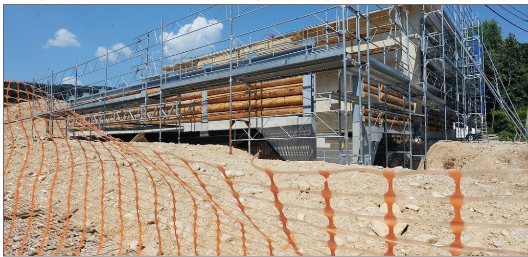
La chaufferie des Plattets est en cours de construction. Andrée-Noëlle Pot
